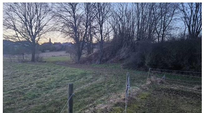
Foto 10: Gehölz auf der Böschung der ehem. Müllkippe, Flurstück 39
