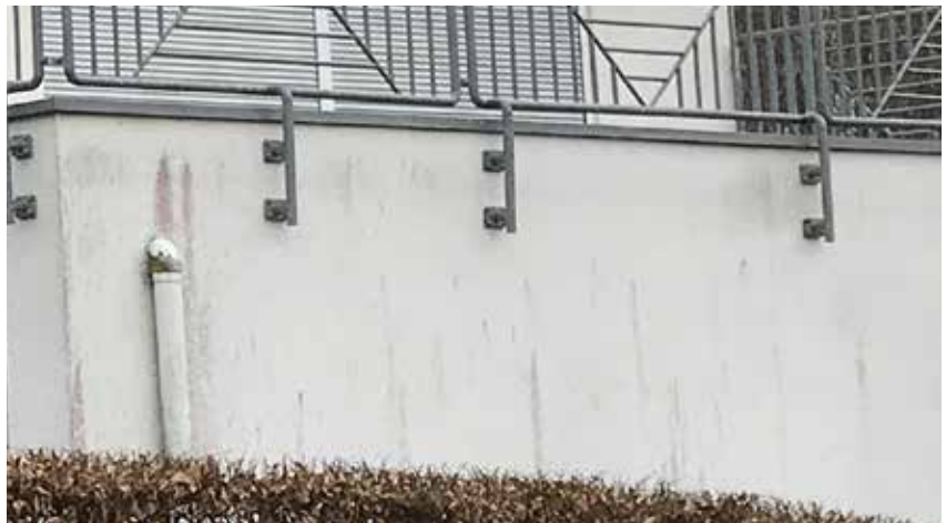
Modernisierungs- und instandsetzungsbedürftiges Gebäude mit geringem Bedarf
