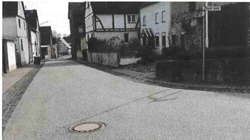
Straßenraum der Ortsdurchfahrt ohne gliedernde Gestalt-, Struktur- und Grünelemente
