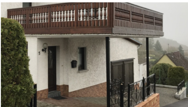
Negativ: im Vergleich zum Hauptgebäude überdimensionierter Balkon
