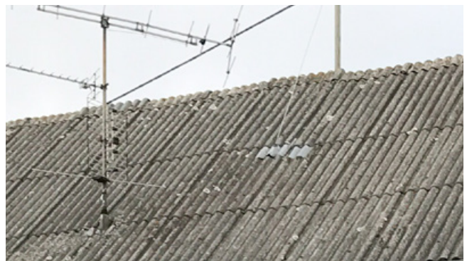
Negativ: Dacheindeckung aus Eternit
