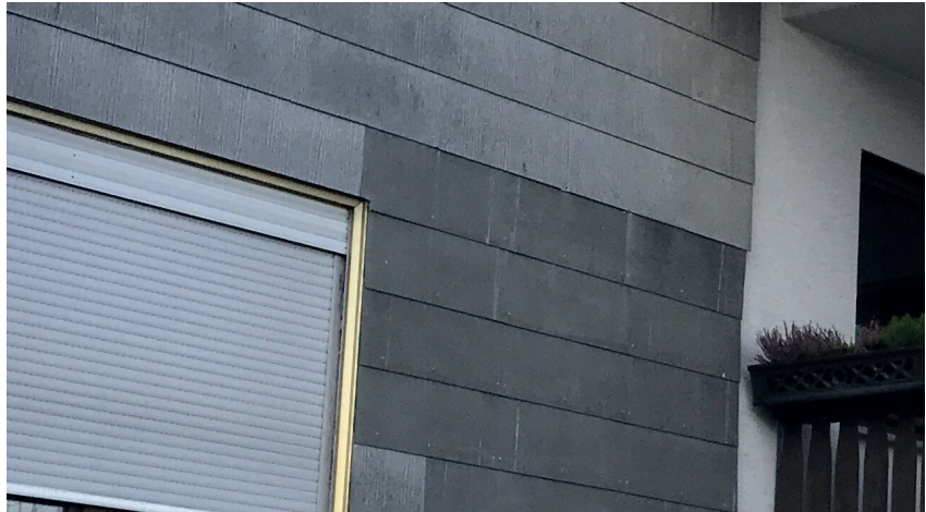
Misstand: Materialität der Fassade
