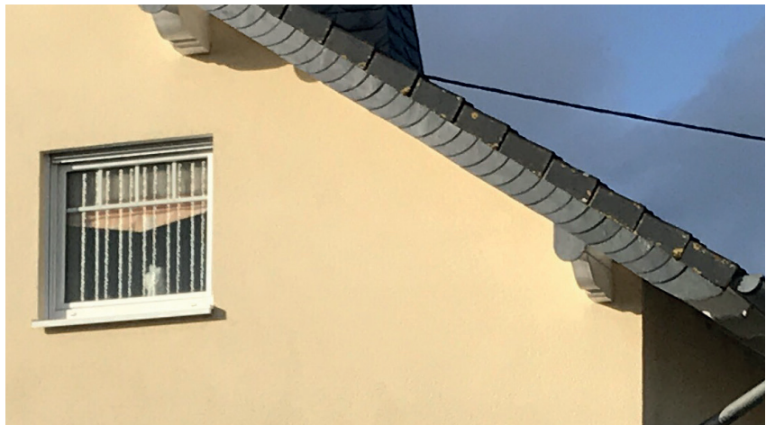
Modernisierungs- und Instandsetzungsbedürftiges Gebäude mit geringem Bedarf
