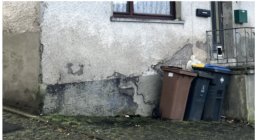
Modernisierungs- und instandsetzungsbedürftiges Gebäude mit hohem Bedarf
