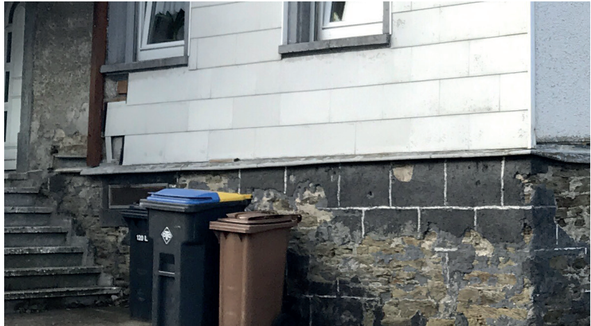
Modernisierungs- und Instandsetzungsbedürftiges Gebäude mit mittlerem Bedarf
