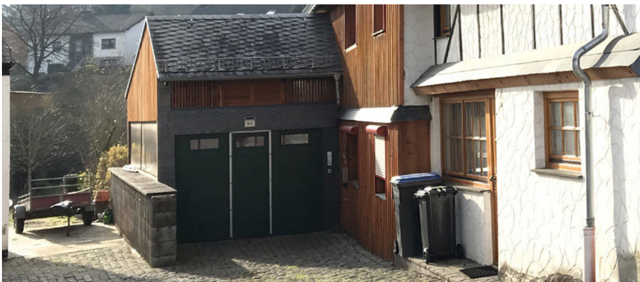
Positiv: Hauptgebäude und Carport bilden eine Einheit
