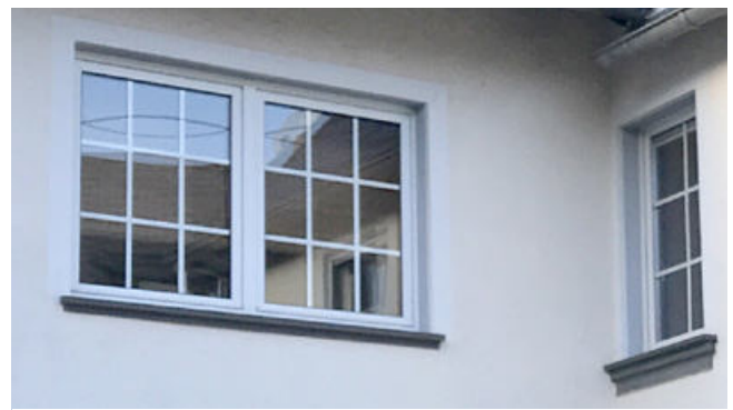
Negativ: aufgeklebte Fenstersprossen
