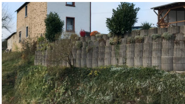
Negativ: Stützmauer aus Betonsteinen
