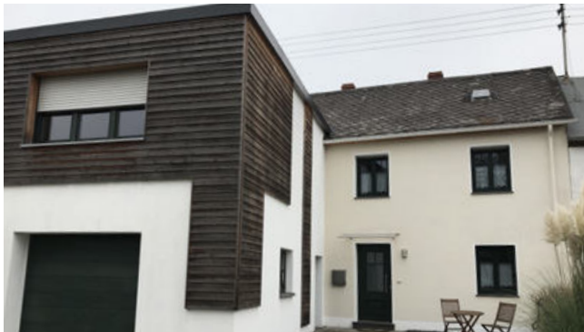
Gestalterische Disharmonie zwischen Hauptgebäude und Anbau
