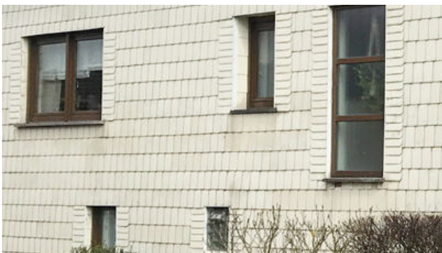
Negativ: variierende Fensterformate innerhalb einer Fassade
