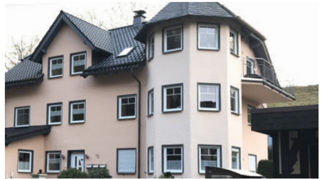
Gestalterische Disharmonie, Turm wirkt überdimensioniert
