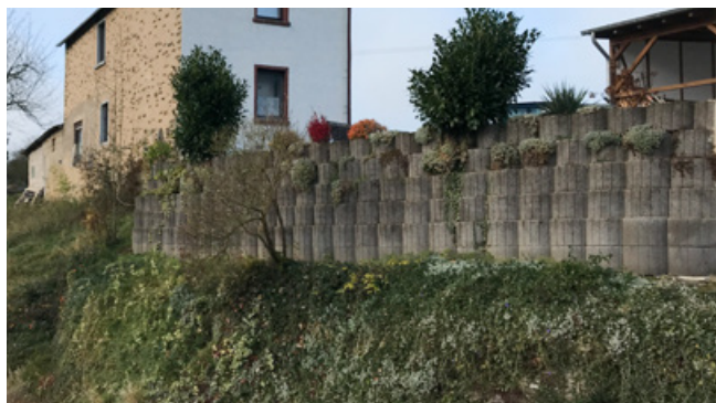
Negativ: Stützmauer aus Betonsteinen
