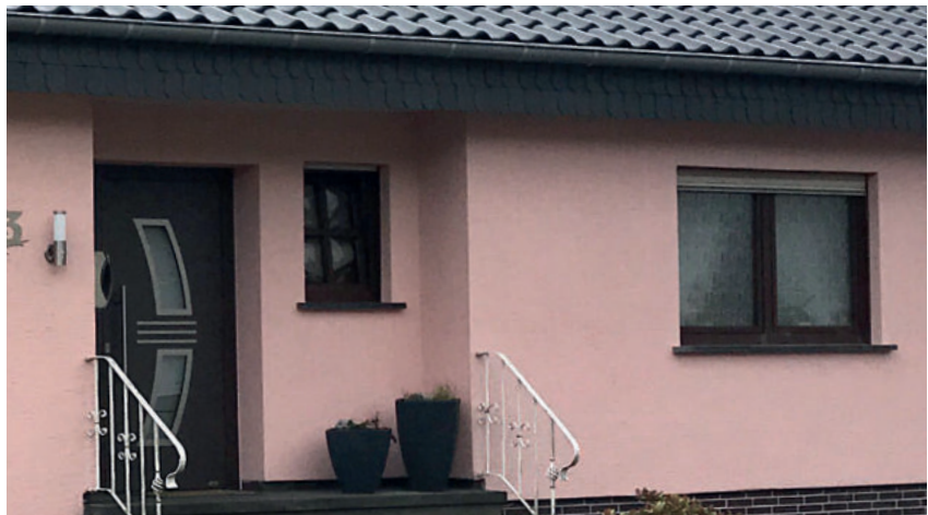
Modernisierungs- und instandsetzungsbedürftiges Gebäude mit geringem Bedarf
