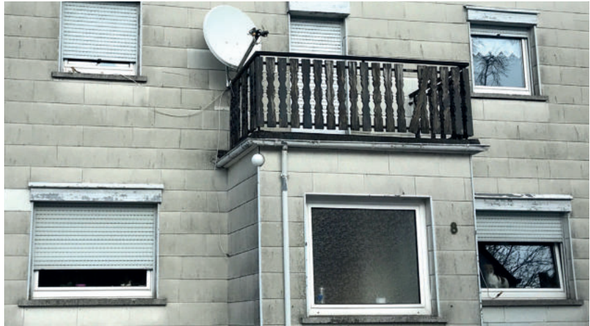
Misstand: Materialität der Fassade
