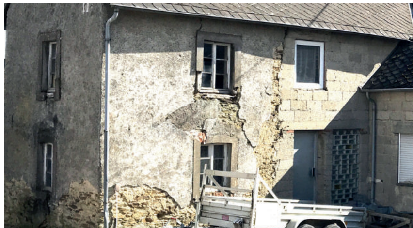
Modernisierungs- und instandsetzungsbedürftiges Gebäude mit hohem Bedarf
