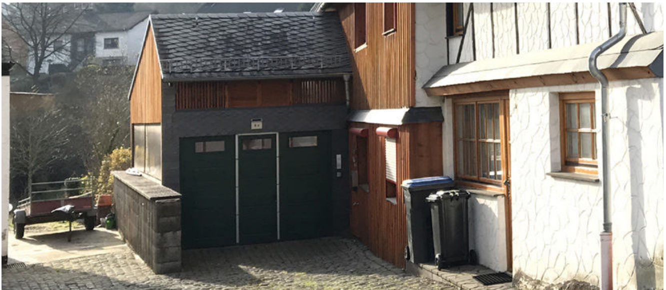
Positiv: Hauptgebäude und Carport bilden eine Einheit
