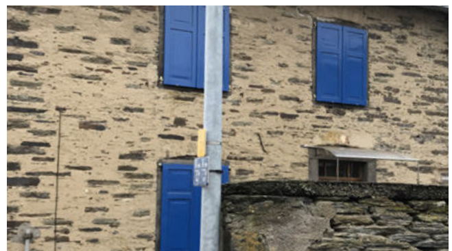
aufdringliche Farbgebung (Fensterrahmen, Klappläden)
