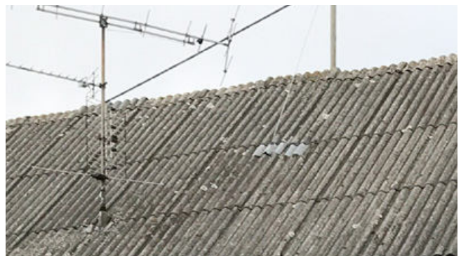
Negativ: Dacheindeckung aus Eternit
