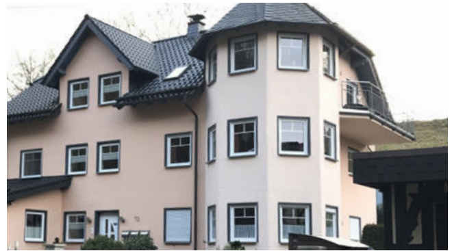
Gestalterische Disharmonie, Turm wirkt überdimensioniert
