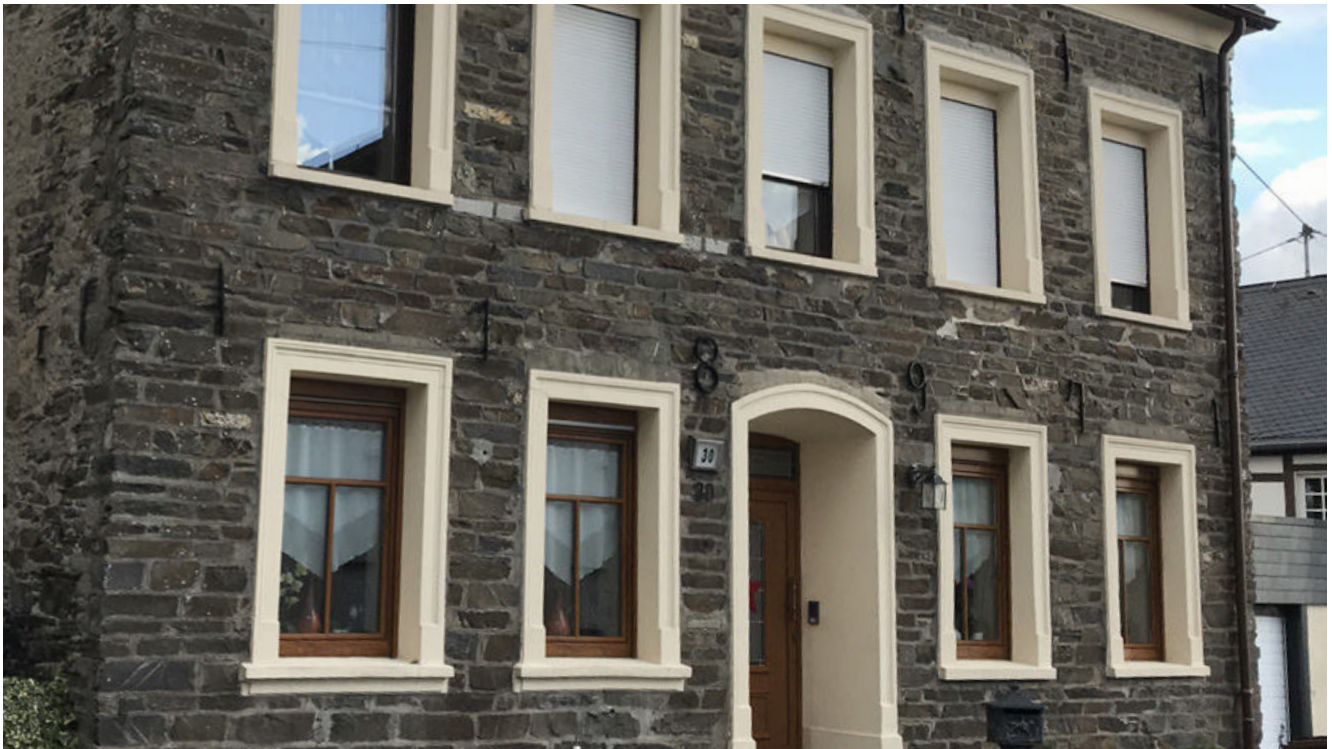
Positiv: auf Bestand abgestimmte Fensterelemente
