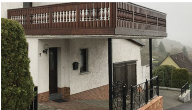
Negativ: im Vergleich zum Hauptgebäude überdimensionierter Balkon
