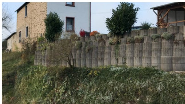
Negativ: Stützmauer aus Betonsteinen
