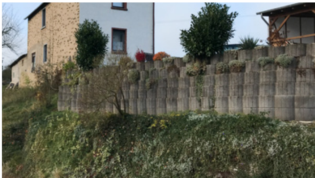
Negativ: Stützmauer aus Betonsteinen
