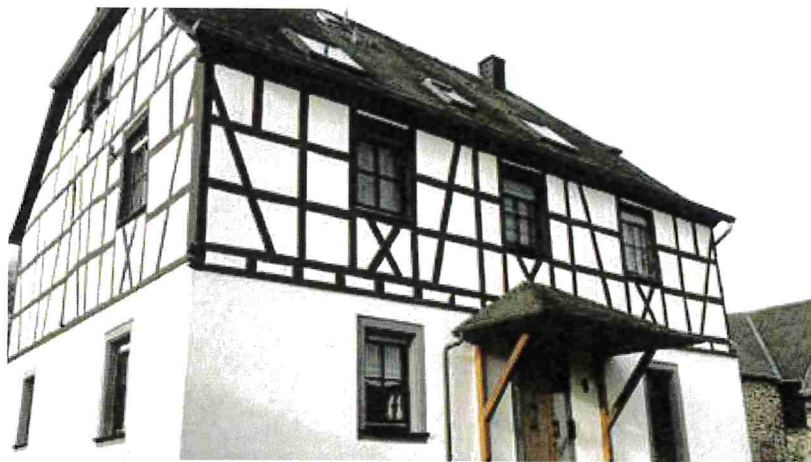
Ortsbildprägendes Gebäude in der Oberstraße
