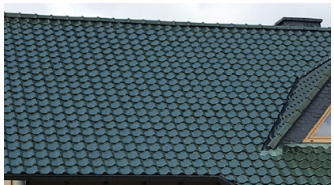
Negativ: Dacheindeckung mit glasierten grünen Ziegeln
