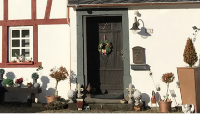
Positiv: die Tür fügt sich farblich harmonisch in die Fassade ein
